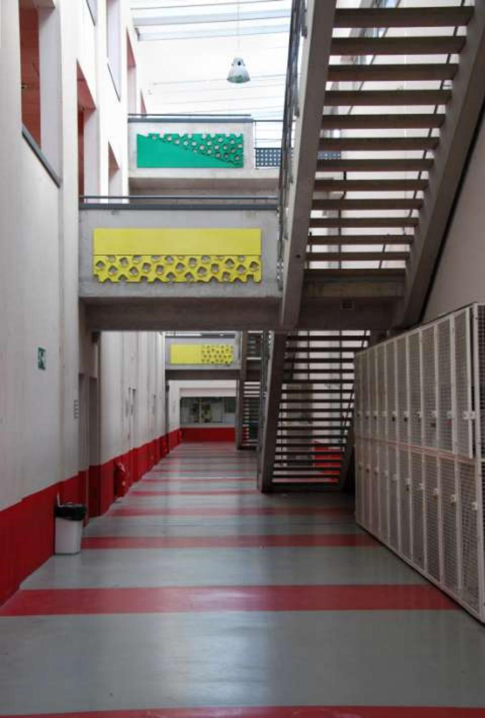
**Appliquée sur des plaques en tôle d'acier de 20/10 d'épaisseur, tôles dites « tôles blanches » ou « tôles froides », la couleur va de la plus lumineuse, dans la zone basse la plus sombre, à la plus sourde dans la zone haute, la plus offerte à la lumière.**
