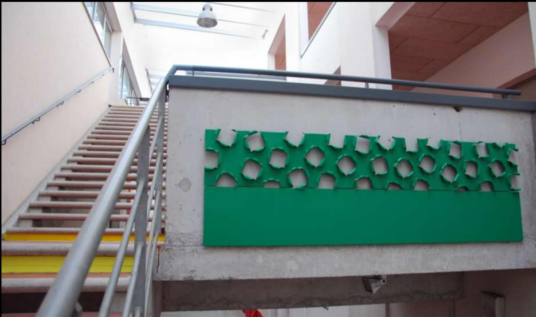
**Chaque élément de tôle peinte pèse de 15 à 20 kg et est fixé à la paroi par quatre ou cinq tenons d'acier de 12 mm de diamètre et 80 mm de longueur soudés à l'arrière de la tôle et scellés dans le béton à l'aide de résine époxy.**
