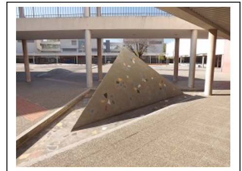
Fontaine à l'entrée, dans le projet initial était prévu un mur d'eau.
