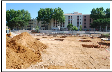
Collège Reynier en travaux
