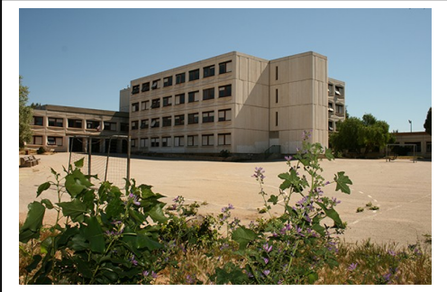
Collège Reynier avant travaux
