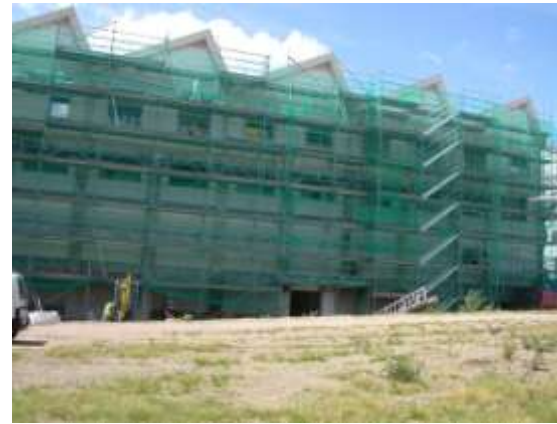
Grillage vert (protection échafaudage)
