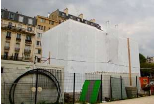
Bâches blanches (travaux)
