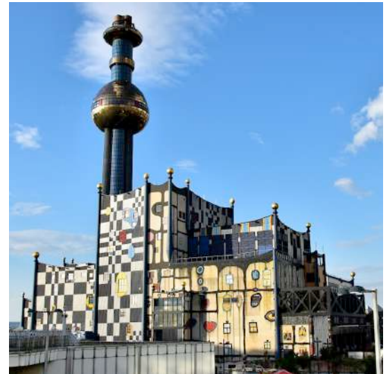
Centrale de chauffage urbain de Spittelau
