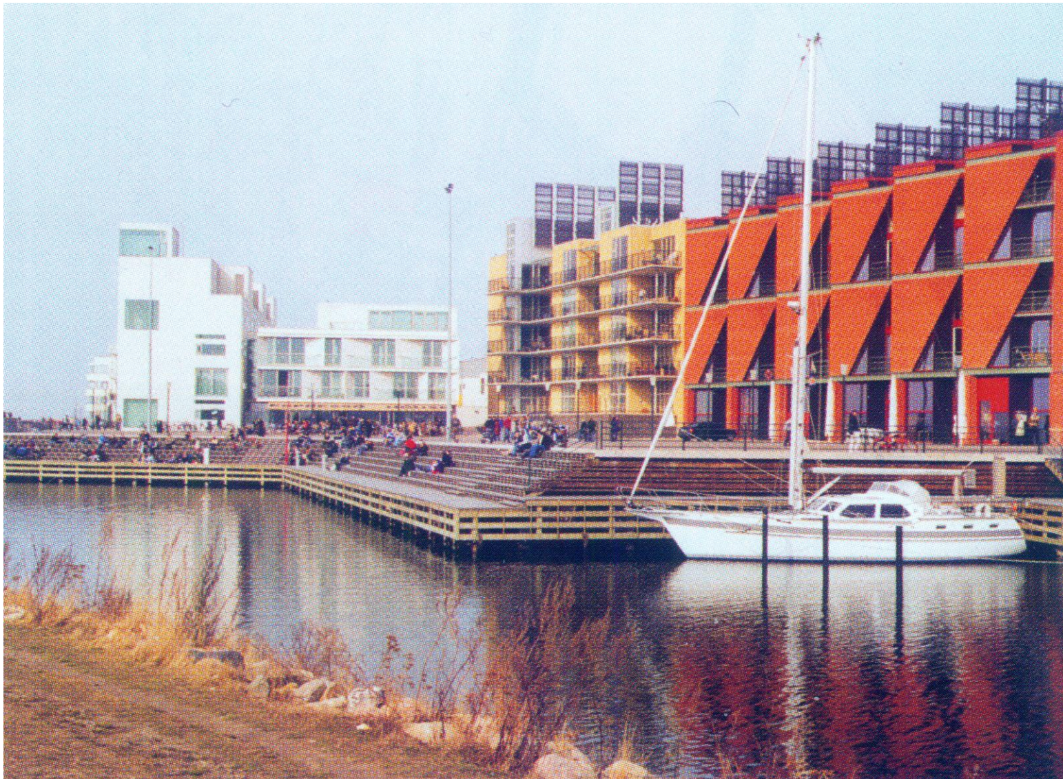
Malmö : La marina de Bo01. Les capteurs sont perpendiculaires aux façades.
