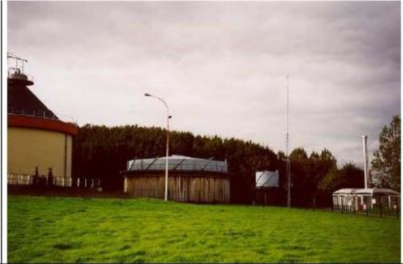
Vue partielle d'un digester et des unités de stockage du biogaz (Lille, France). Moteur à biogaz et distribution de biogaz à la pompe de la station d'épuration de Lille
