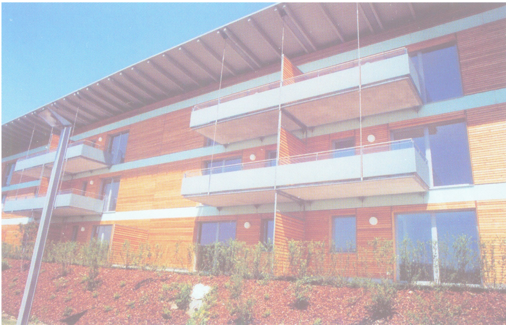
Malmö : Les immeubles bioclimatiques conçus par Norman Foster
