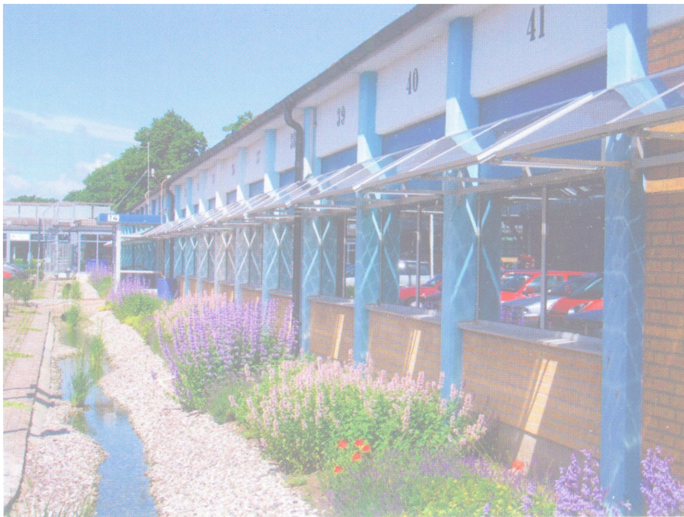
Malmö. Des panneaux photovoltaïques dirigent l'eau de pluie vers le système de drainage.
