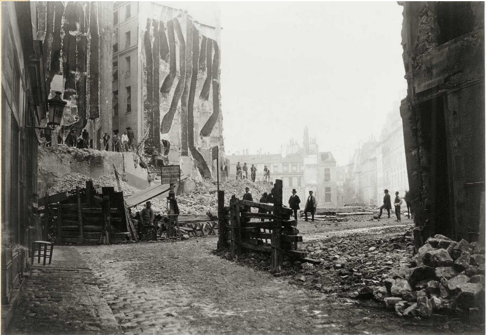
Démolition. Photo de Charles Marville. 1876-1877. BNF
