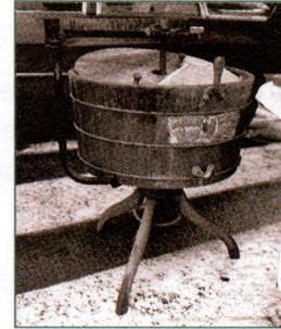
② **Principe** : il faut verser l'eau chaude dans la machine et brasser le linge avec une manivelle pour le laver.
